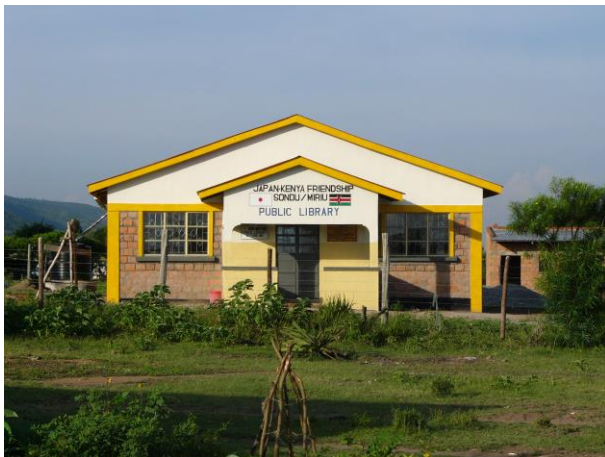
日本ケニア友好公共図書館の正面玄関（2004年10月建設）
